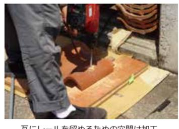
瓦にレールを留めるための穴開け加工
