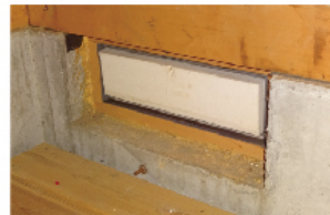
下：冬と夏、床下の換気を閉じ気密性を高める。
