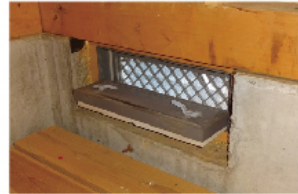
上：春と秋、床下の換気を開け空気を取り込む。
